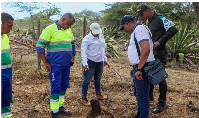
Por día, se están perdiendo cerca de 26 millones de litros de agua potable, equivalente a más de 2.500 carrotanques.
